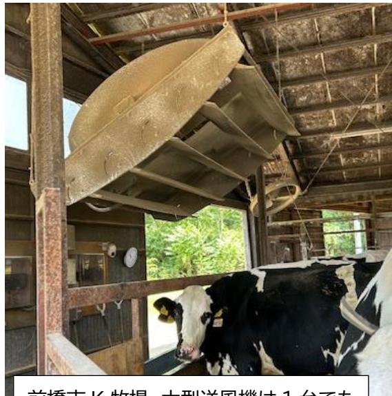
前橋市 K 牧場 大型送風機は1台でも広い面積に風を送れます。
